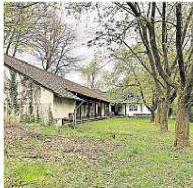
Auf dem Gelände im Eifgen soll sich etwas tun.
